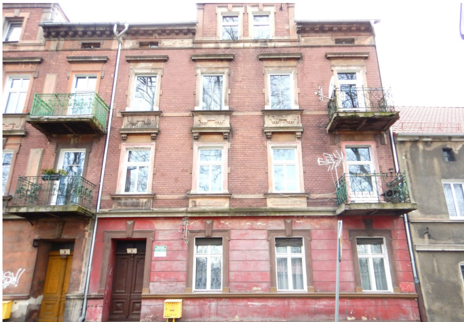
Ogólny widok budynku
